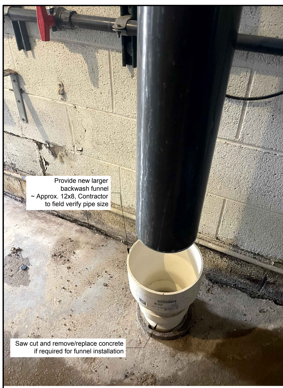
D BACKWASH FUNNEL - EXISTING CONDITION N.T.S.
